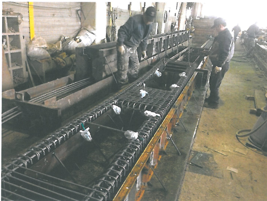
그림 2.3.11 철근 설치
