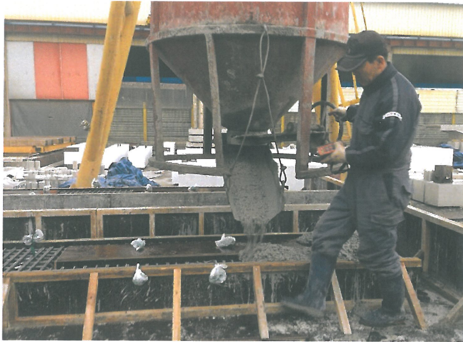
그림 2.3.14 콘크리트 타설
