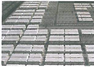
<KASIER Void Slab System(일본)>
